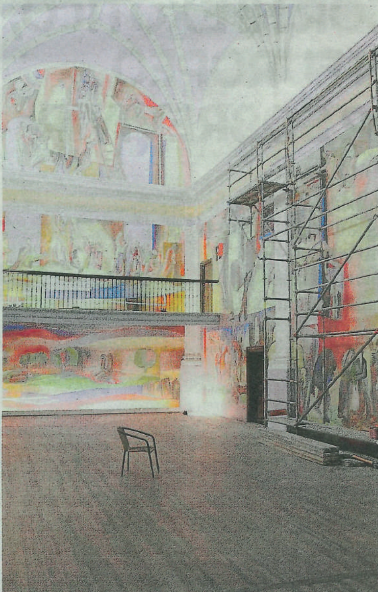
Aspecto de la pared trasera de la iglesia y de uno de sus laterales.
